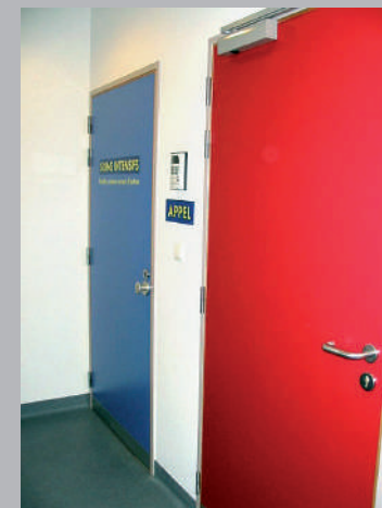
✓ Murs, sols et portes sont suffisamment contrastés.
