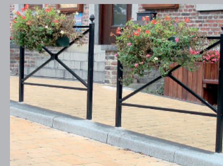
✔ Barrière contrastée et hauteur conforme
