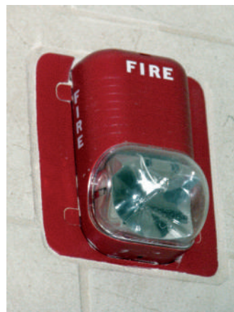
✓ Voorbeelden van een brandalarm en van rookdetectoren met lichtflitsen
