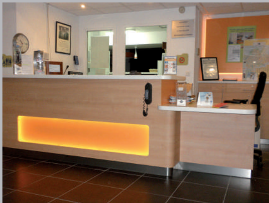
✗ Verlaagd werkblad is niet diep genoeg
