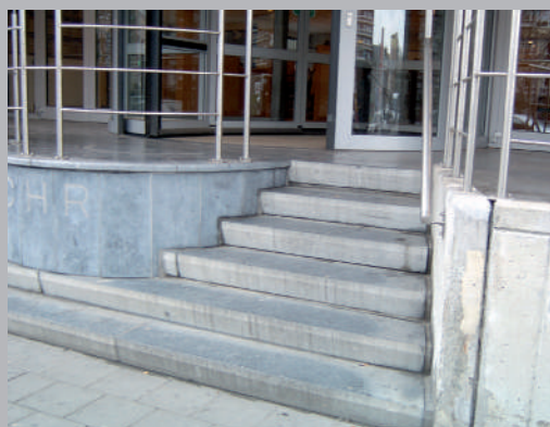
✗ Niet-contrasterende trapneuzen
