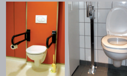
✗ Bevestigingsschoen in de transferzone
