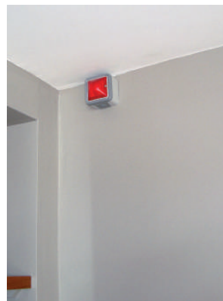
✓ Voorbeelden van een brandalarm en van rookdetectoren met lichtflitsen
