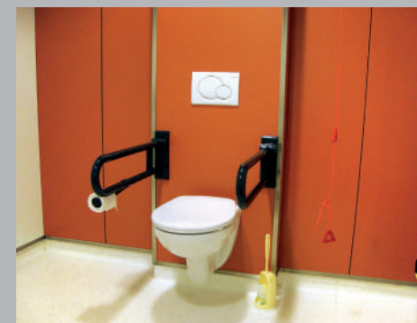
✓ Aangepast toilet met twee transferruimten
