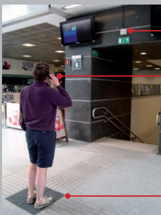
Baken met vooraf ingesproken bericht.
