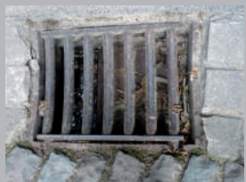
✗ Afvoergoot met gleuven > 2 cm
