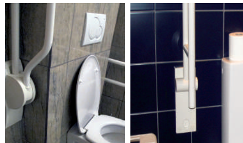
✓ Bevestigingsschoen buiten de transferzone
