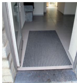
✅ Deurmat ingewerkt in de vloer
