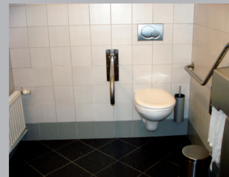
✓ Aangepast toilet met één transferruimte recht tegenover de deur
